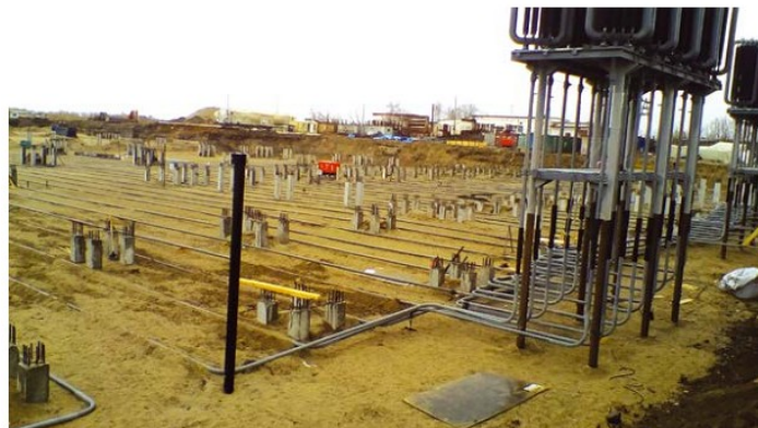
Рис. 1. Монтаж горизонтальных систем термостабилизации на объекте «АО «Жатайская судовой верфь»
