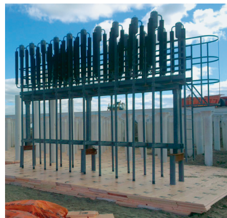
Рис. 2. Система термостабилизации производства ООО «НПО «Север» применительно к резервуарам
