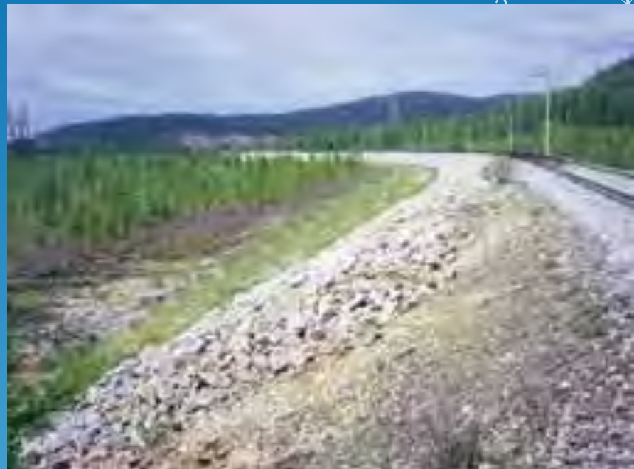
Охлаждающая каменная наброска на откосах (фото профессора Ашпиза Е.С.).
