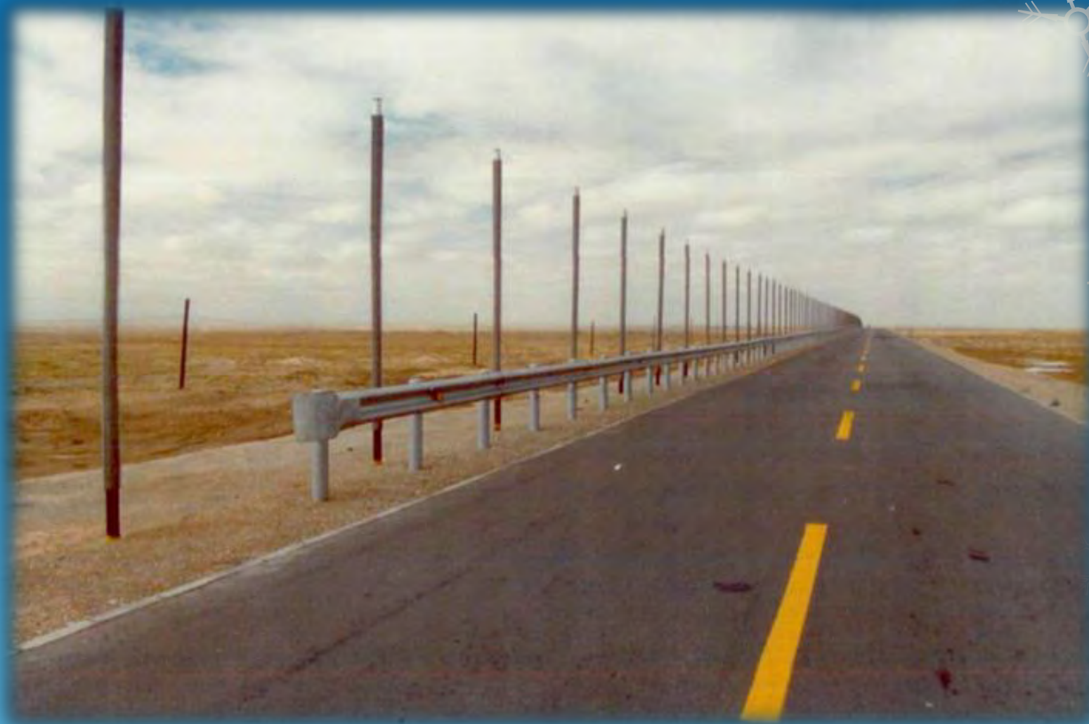
Термостабилизаторы (СОУ) фирмы «Сан-Лидер» (Китай), установленные на автодороге Цинхай-Лачжоу в КНР (фото профессора Кондратьева В. Г.)
